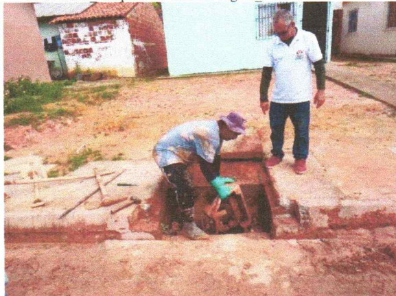
20-04-2021 Limpeza de caixa de esgoto Platô 1
