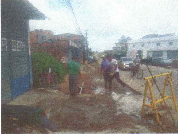
13-04-2021_Reparo de caixa de esgoto e calçada Avenida Tancredo Neves - Centro
