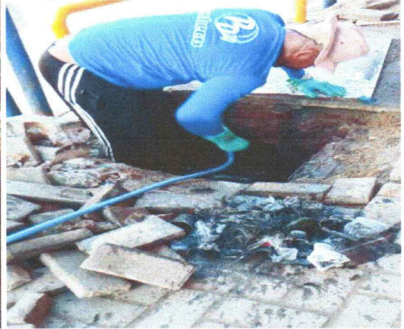
22-04-2021_Desentupimento de esgoto_Platô
