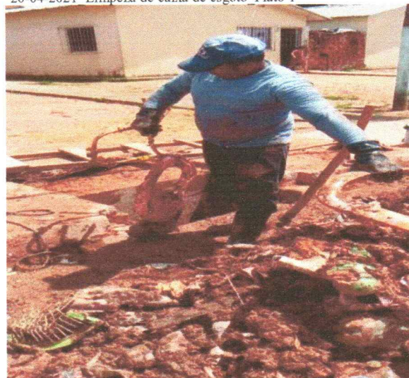
20-04-2021 Limpeza de caixa de esgoto Platô 1
