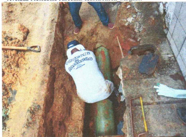
29-04-2021_Manutenção de caixa de galeria de esgoto Avenida Presidente Juscelino Kubitscheck Maguari
