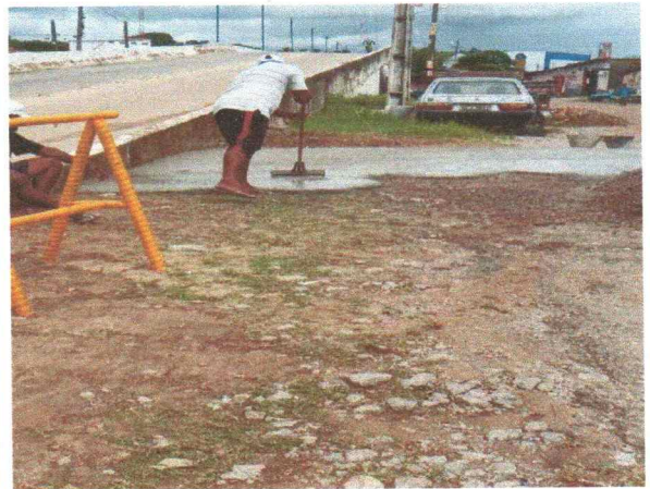
29-04-2021_Manutenção de Galeria de esgoto_Recanto Itaperibu Santa Gorete
