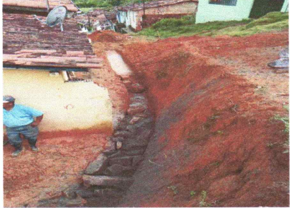
05-04-20221_Construção de muro de arrimo Alto da boa esperança – Lotes
