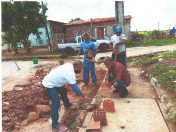
26-04-2021_Desentupimento e Manutenção de caixa de esgoto Platô
