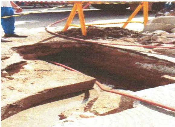
09-04-2021_Desentupimento e Manutenção de caixa de esgoto Avenida Presidente Juscelino Kubitscheck – Centro
