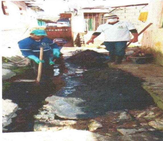
26-04-2021 Limpeza de galeria de esgoto_Platô 1
