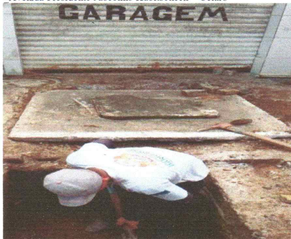
09-04-2021_Desentupimento e Manutenção de caixa de esgoto Avenida Presidente Juscelino Kubitscheck – Centro
