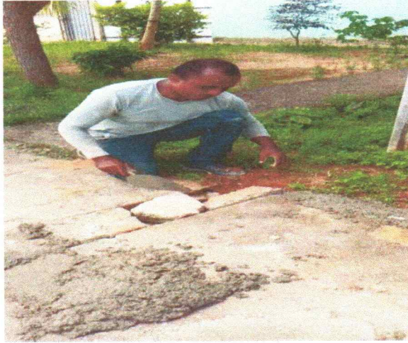
26-04-2021 Manutenção de caixa de esgoto_Platô 1
