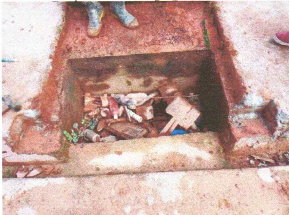
20-04-2021 Limpeza de caixa de esgoto Platô 1
