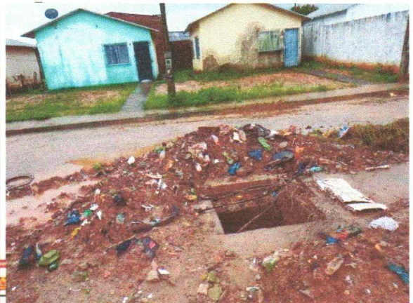
16-04-2021_Limpeza de caixa de esgoto_Santa Clara Conhecido como macaco
