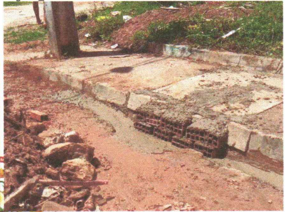
26-04-2021_Desentupimento e Manutenção de caixa de esgoto Platô
