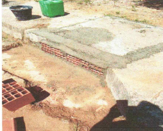
23-04-2021_Desentupimento de caixa de esgoto_Platô 1
