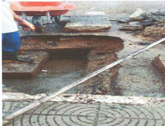
29-04-2021_Manutenção de caixa de esgoto_Rua Dom Luiz_Centro
