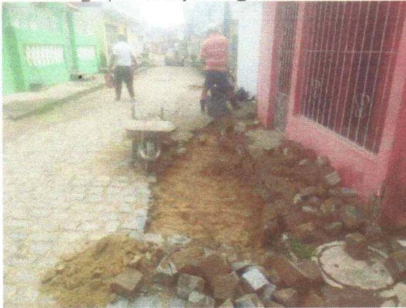
26-04-2021_Desentupimento e Manutenção de caixa de esgoto Platô
