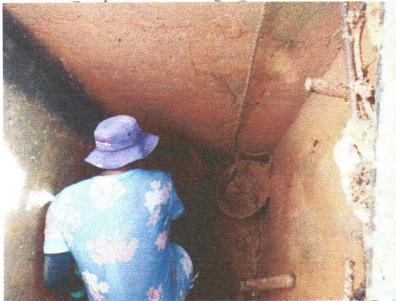
19-04-2021_Limpeza de caixa de esgoto_Platô 1
